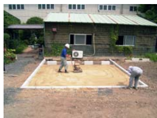
②クッション砂敷均し
