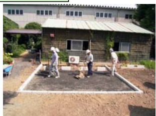
①路盤整正転圧
