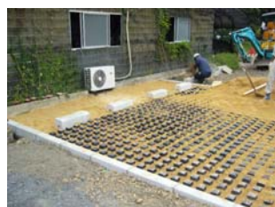
⑤客土敷均し
