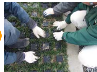
⑦歩行補助材設置
