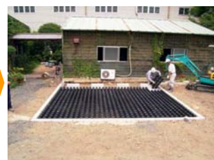
④本体パネル設置
