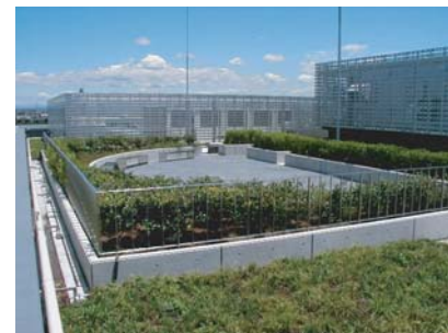
研究センター建屋の屋上
