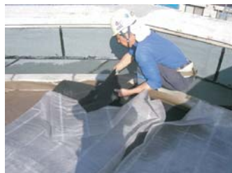
面状ドレインシートの敷設
