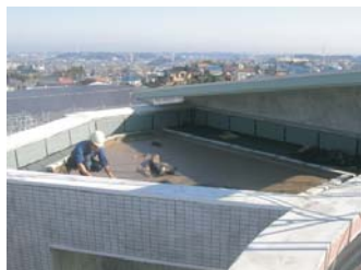
防根シートの敷設
