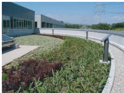
研修所建屋の屋上
