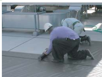
防根シートの敷設
