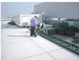
ユニットコンテナの敷設
