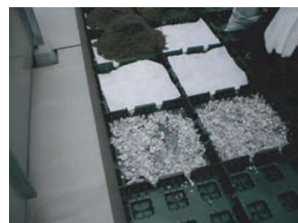
排水層の設置
