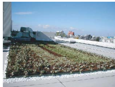
病院建屋の屋上
