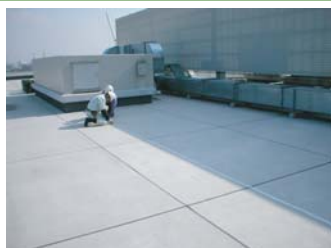
施工前 (位置出し)
